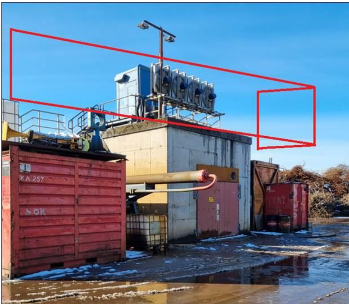
Figur 3-3: Skjermingsforslag ved innmating til Lindemannsaks, sett fra nord. Omriset av skjermingsforslaget er markert med rødt.
