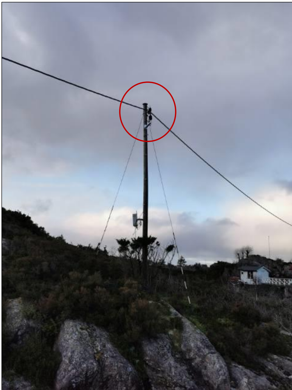
Figur 1-5: Bilde av målestasjon i måleposisjon 3 iht. Figur 1-1. Målestasjonen er plassert ved fritidsbygg med gnr./bnr. 19/61, som ligger vest for industriområdet.
