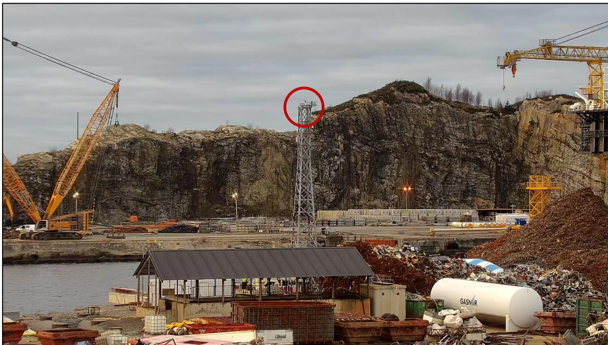
Figur 1-2: Bilde av målestasjon i måleposisjon 1 iht. Figur 1-1. Målestasjonen er plassert i toppen av masten på industriområdet. Målestasjonen henter også inn meteorologiske data.
