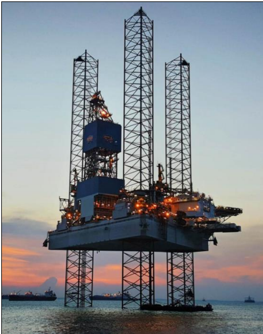
Figur 2-6: Bildet av riggen Noble Lloyd Noble (NLN) som ligger i dokken. Bildet er hentet 02.03.2021 fra www.norscrapwest.no .
