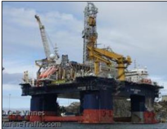
Figur 2-4: Bildet av riggen Island Innovator, som ligger ved 90m kaien. Bildet er hentet 14.01.2021 fra www.marinetraffic.com .
